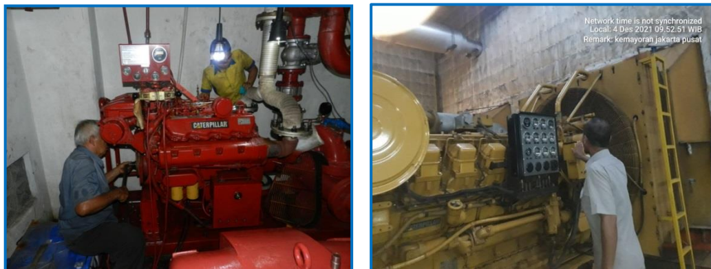
Gambar 6. Pemeliharaan mesin Genset dan Diesel Hydrant
