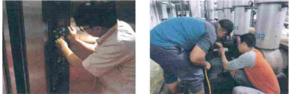
Gambar 13. Pemeliharaan Lift dan AC Sentral Gedung Basarnas
