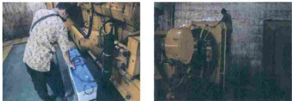
Gambar 14. Pemeliharaan Mesin Genset dan Diesel Hydrant
