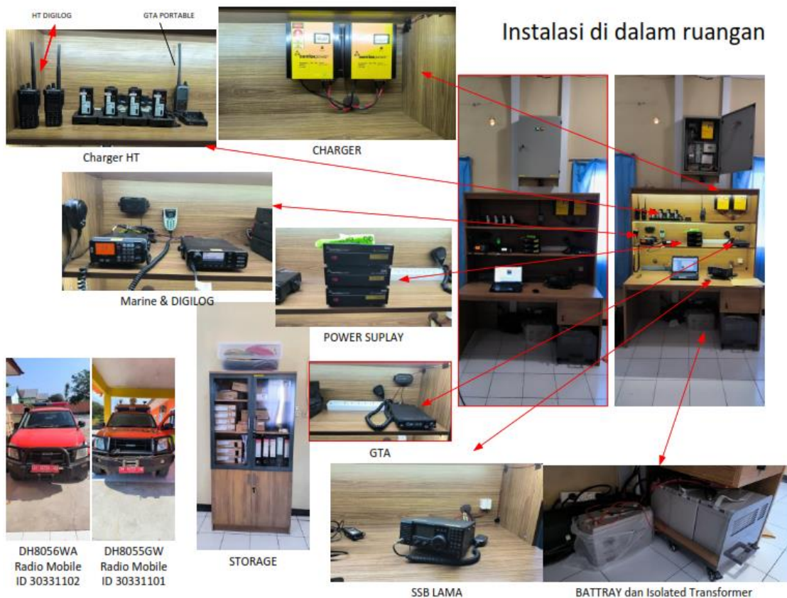
Gambar 9 Instalasi Peralatan Komunikasi pada Kantor Pencarian dan Pertolongan
