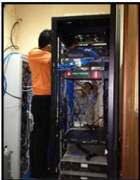
Proses pemasangan switch di Kansar Denpasar
